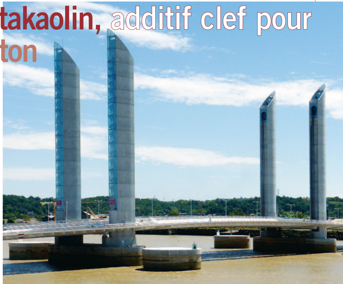
Le pont Chaban-Delmas de Bordeaux a vu l'utilisation de bétons additionnés de métakaolin pour la construction des pylônes.
